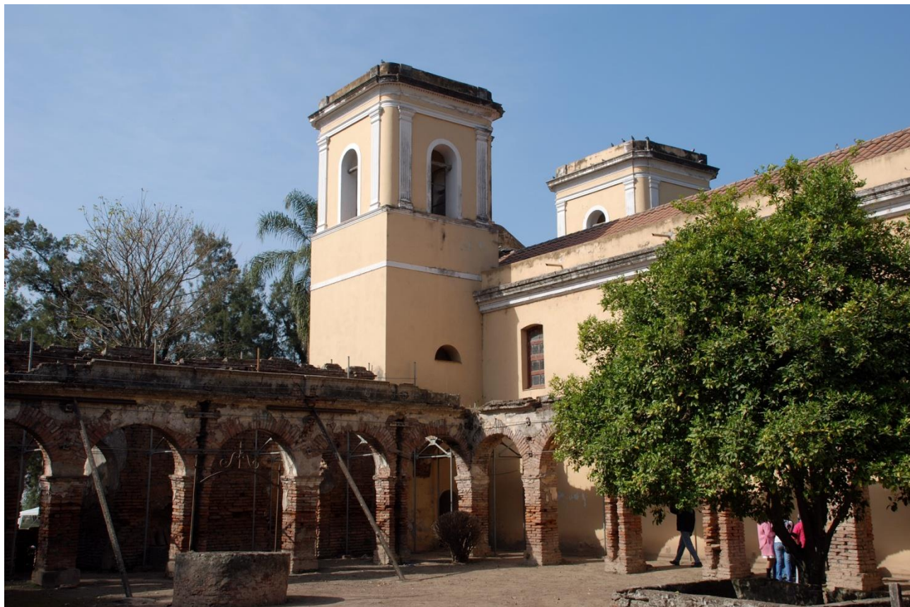
Vista exterior trasera de la zona de los claustros (en ruinas) y la capilla
